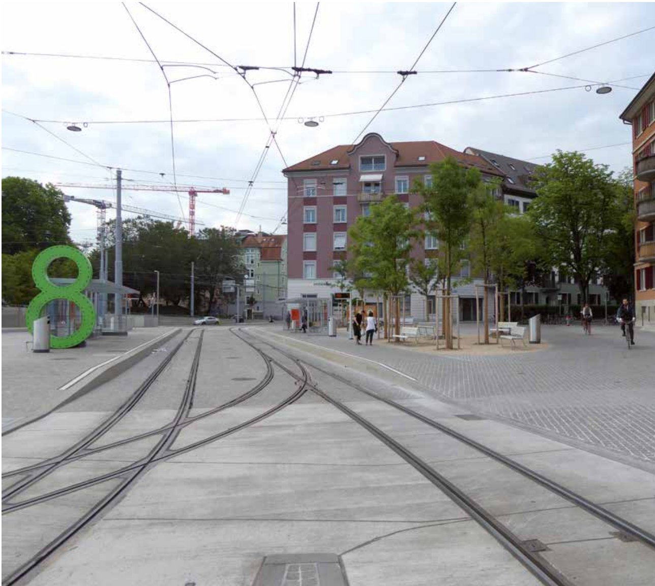
Neu gestalteter Hardplatz. Foto: Stadt Zürich, Tiefbauamt
