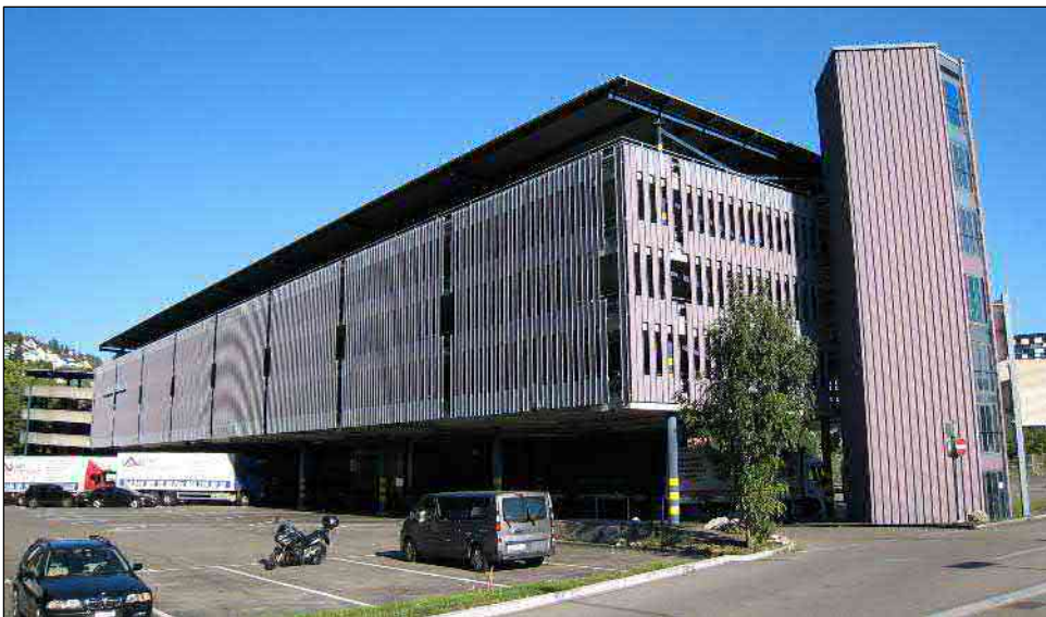
Abbildung 3-3 Parkhaus Hardturm (Quelle: ProjektBeweger, 30.09.2016)
