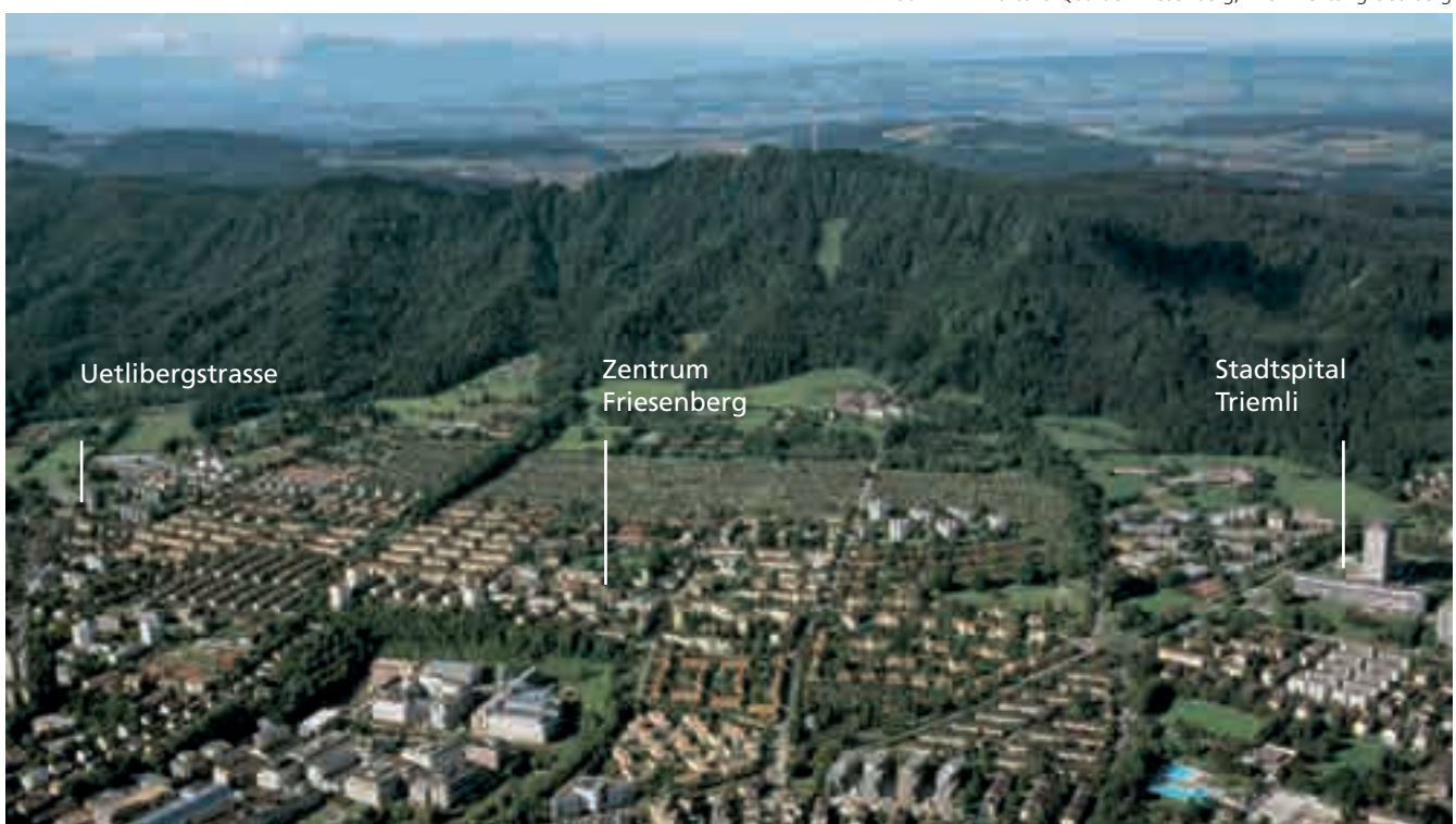
Abb. 1: Luftbild Quartier Friesenberg, Blick Richtung Uetliberg
