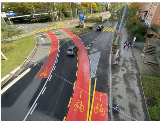
Bucheggplatz: Problematisch war unter anderem die Konfliktsituation zwischen Velos, die nach links in Richtung Hofwiesenstrasse/Oerlikon weiterfahren und Fahrzeugen, die rechts in die Bucheggstrasse abbogen. Durch die Anpassung des Abbiegewinkels wurde die Situation verbessert. Jetzt nehmen die Autofahrenden das Rechtsabbiegemanöver bewusster wahr und fahren langsamer. Ausserdem wurden die Velostreifen auf zwei Meter verbreitert.
