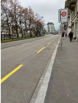
Kasernenstrasse (Richtung Stauffacher): Die Kasernenstrasse bot den Velofahrenden wenig Platz. Deshalb wurden die Parkfelder Richtung Stauffacher entfernt und ein durchgehender Velostreifen markiert.
