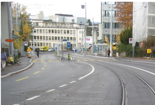
Gloriatrasse: An der Gloriatrasse bewegt sich der motorisierte Individualverkehr neu talwärts auf der gleichen Spur wie das Tram. Mit dieser Massnahme wurde genügend Platz geschaffen, um bergwärts einen Velostreifen zu markieren.
