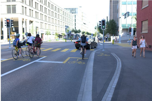
Lagerstrasse: Bei der Neugestaltung der Lagerstrasse wurden beidseitig Velostreifen markiert, die Sicherheit an den Lichtsignalanlagen mit Velosäcken erhöht sowie das indirekte Linksabbiegen ermöglicht.
