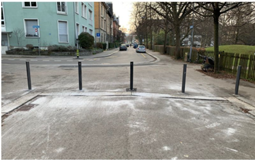
Minervastrasse: An der Minervastrasse 40 und 46 wurden die Randsteine abgesenkt, um das Fahren auf der kommunalen Veloroute angenehmer zu gestalten.
