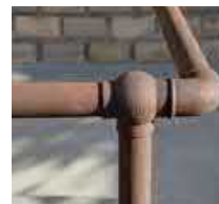
Kat. C. Einfriedung/Geländer C.10 Geländer 1
