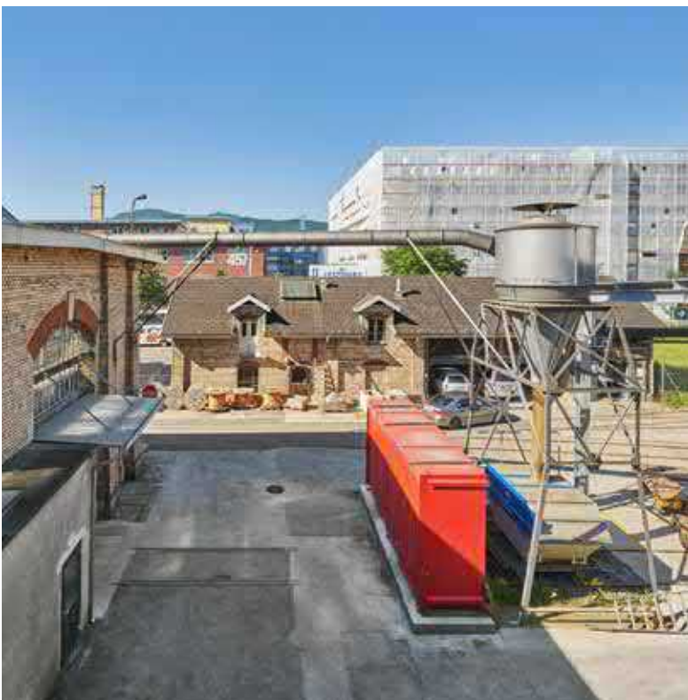
Gebäude Y, im Hintergrund Komplex 457 und «fifty-fifty» (im Bau).
