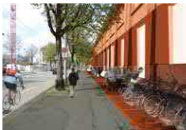
Dynamische Vorzone: Sie gelten als Andockungsmöglichkeiten für die Nutzenden des Areal. Breite Fenster erlauben gewisse Einblicke in die Kleinmanufakturen, Veloabstellplätze und eine begrenzte Anzahl an Autoparkplätzen werden hier angeboten.
