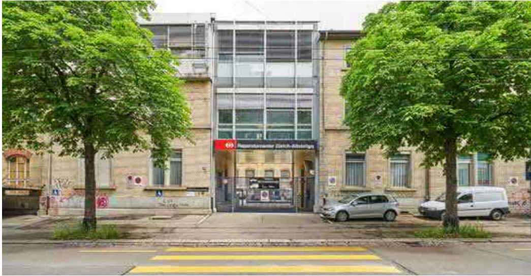
Durchgang im Gebäude A von der Hohlstrasse her.
