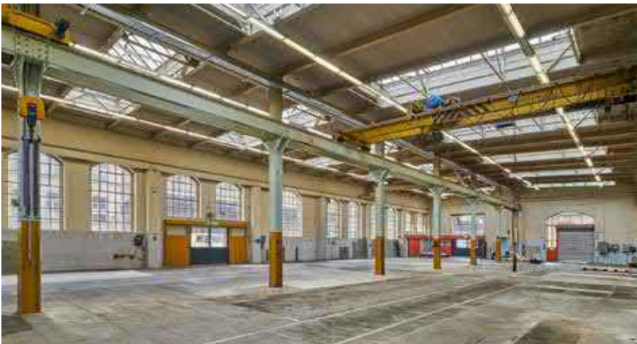
Innenansicht Halle D.
