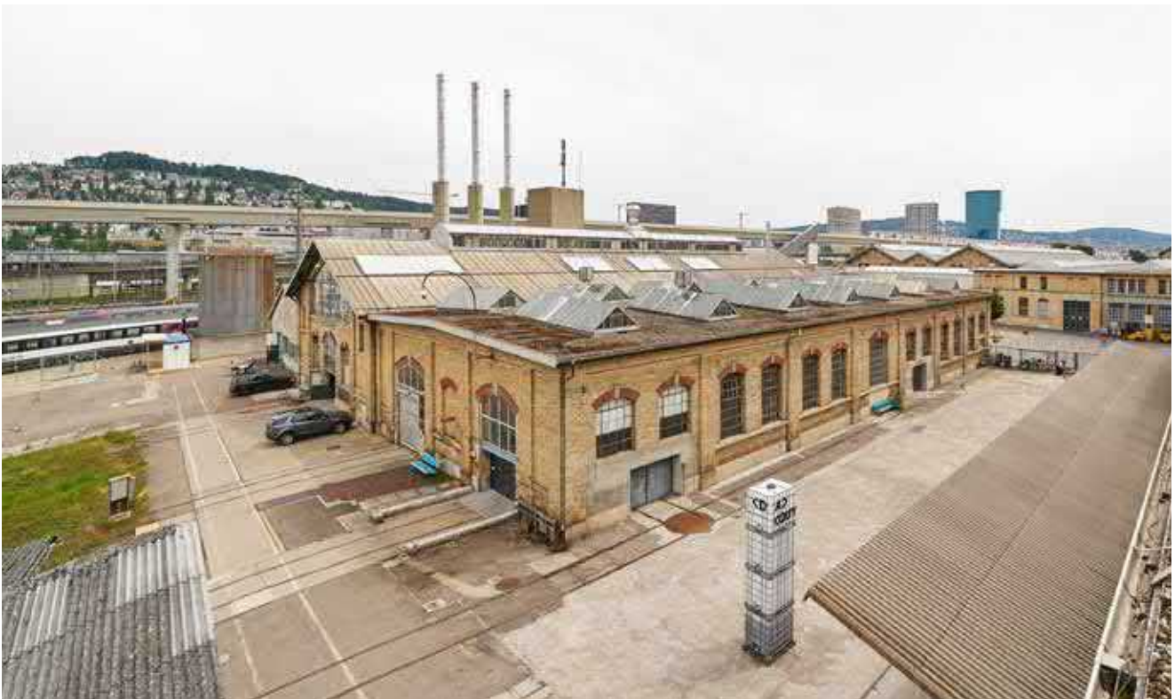
Halle D, im Hintergrund Heizentrale.
