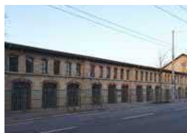
Das Areal besticht durch seine wiederholenden Ziegelbaufassaden mit bogenförmigen Fenstern.
