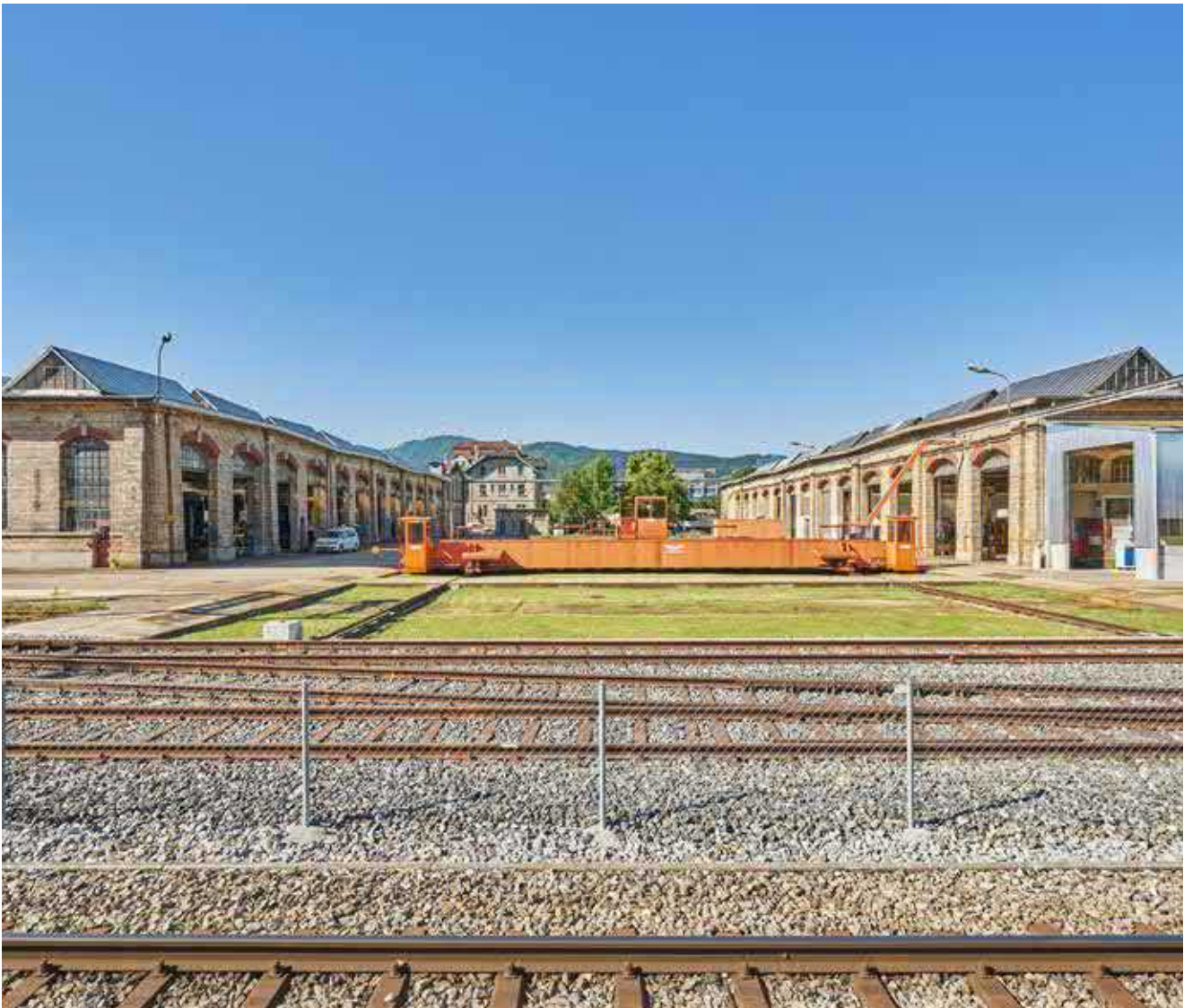
Hof zwischen Halle Q (links) und R (rechts), Sicht Richtung Hohlstrasse.
