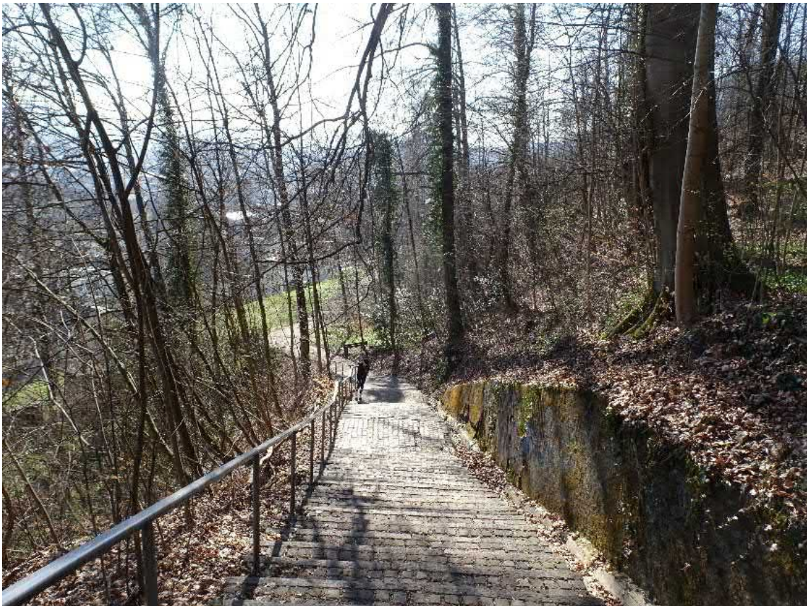
Abb 8. Die Treppenanlage und die Stützmauern überprägen den ehemaligen Hohlweg
