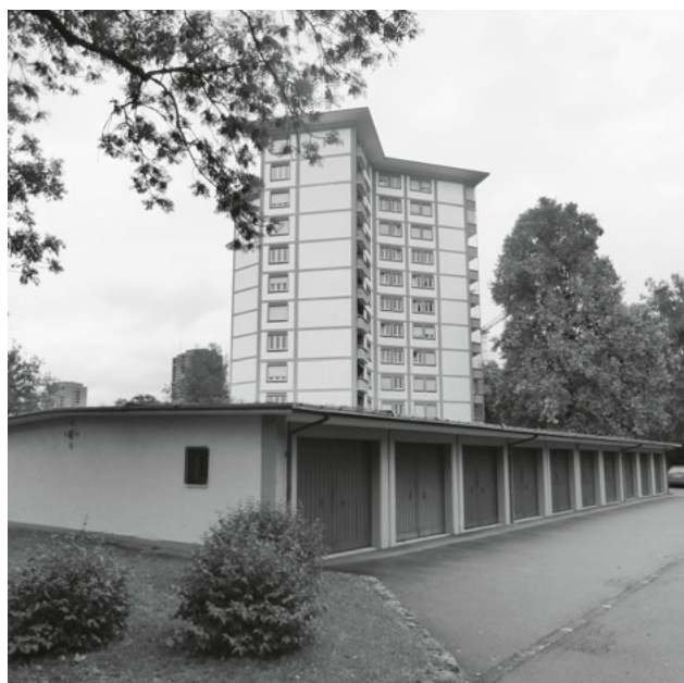
Am Letzigraben entstehen auf Baurechtsland 36 Wohnungen. (Bild: Sven Sennrich)
