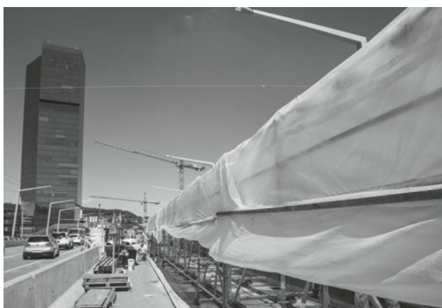
Baustelle Tramverbindung Hardbrücke (Bild: VBZ)
