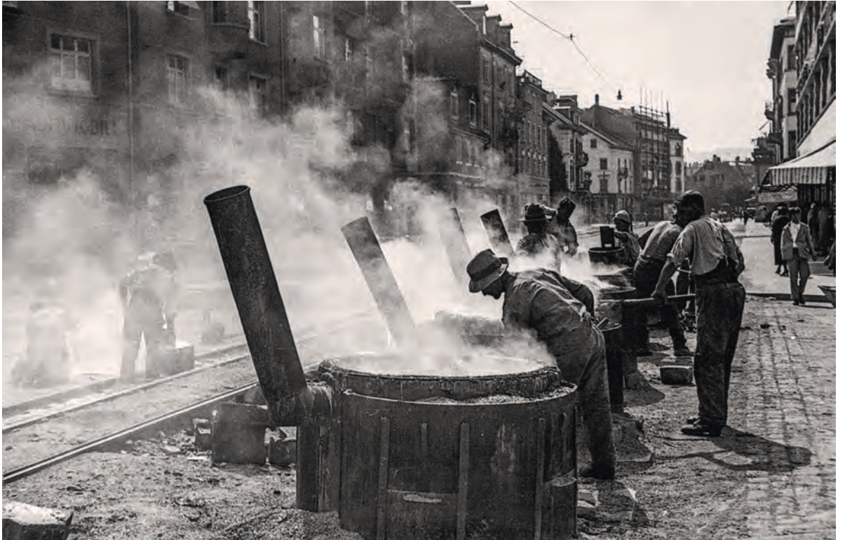
Teerkocher bei Strassen- und Gleisarbeiten an der Badenerstrasse, ca. 1930 (Foto: Emil Acklin)
