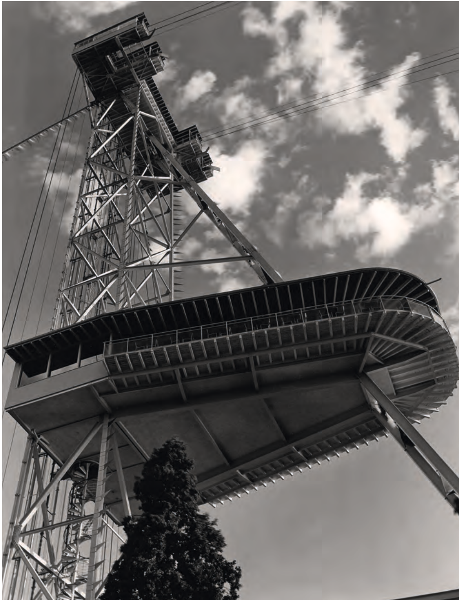
Das Turmrestaurant auf der linken Seeseite
