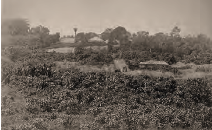
[Bild 5] «Estate Torop Rüegger später Tritschler am Kwaloe-Fluss»
