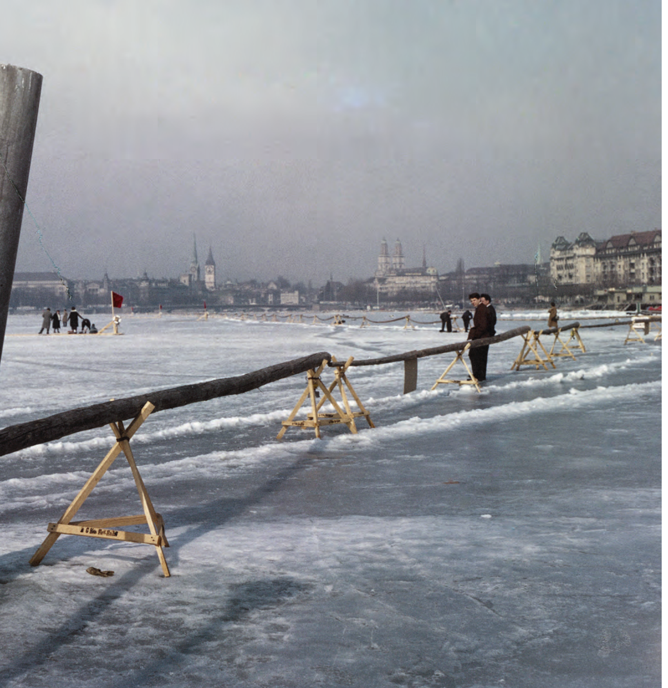
Schrägstellung eines Pfahls beim Dampfschiffsteg Seefeldquai, 1963
