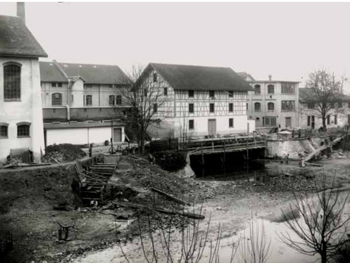
Turbinenhaus der Papierfabrik an der Sihl. Das Fachwerkhaus wurde 1872 erbaut und 2003 abgerissen. Fotografie 1897. (Baugeschichtliches Archiv der Stadt Zürich – künftig: BAZ –, Repro 5272)
