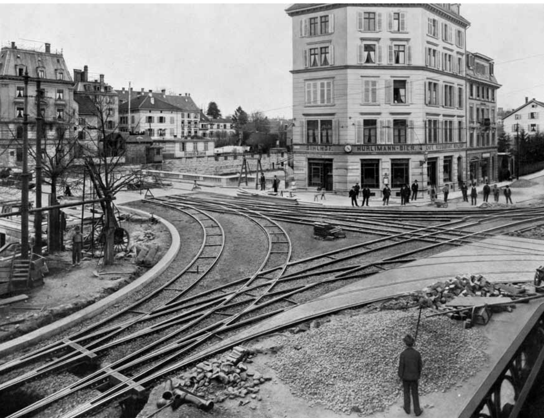
Bau der Geleiseanlage «Sihlbrücke» in Zürich, 1903. Fotografie aus dem Referenzbuch Weichen-Album der Phoenix-Aktiengesellschaft für Bergbau und Hüttenbetrieb in Duisburg. (V.G.c.202.:12.3.Q)
