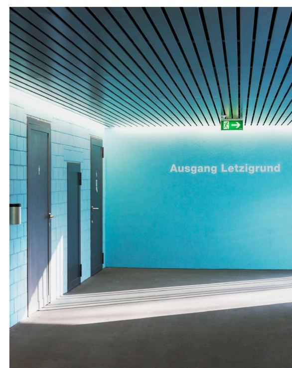
Neuer Fussgängerzugang aus dem Parkhaus Richtung Stadion Letzigrund
