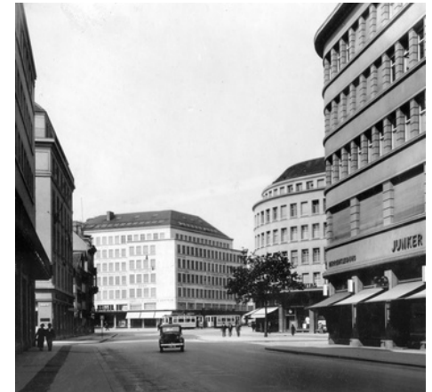
1934: Modernität an der Sihlporte (Foto: BAZ_078544)
