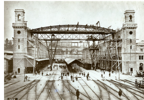
Der neue Hauptbahnhof im Bau 1867 (Foto: BAZ_098164)
