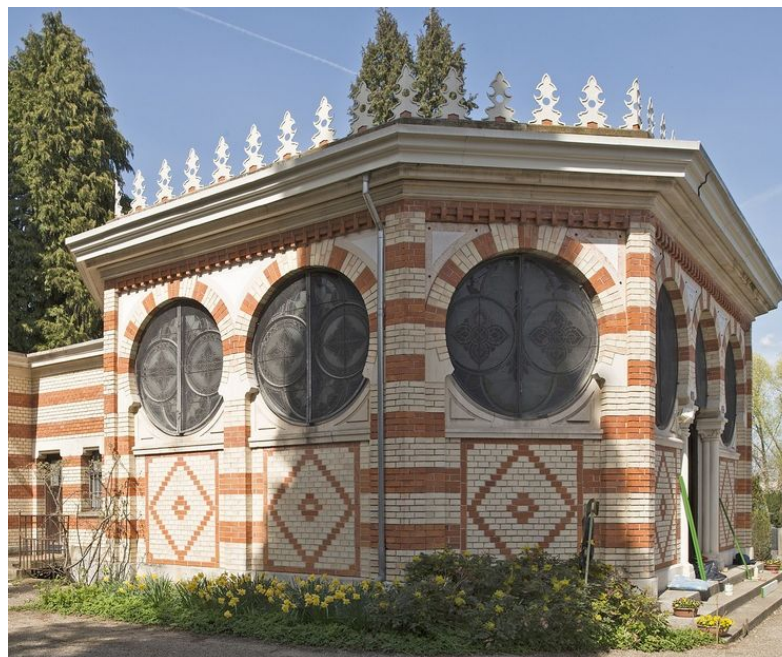
Baudenkmal: Abdankungshalle im Friedhof Unterer Friesenberg (Bild: BAZ_004086, Juliet Haller)
