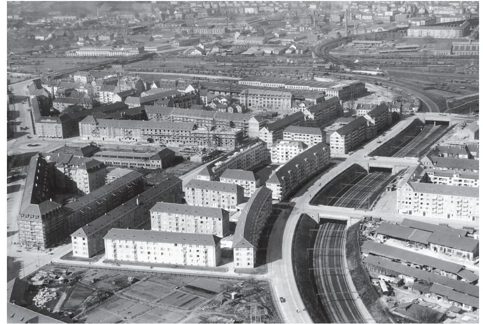
Gemeinnütziger und genossenschaftlicher Wohnungsbau entlang der Seebahnstrasse (Bild: BAZ_058975, Ad Astra-Aero)
