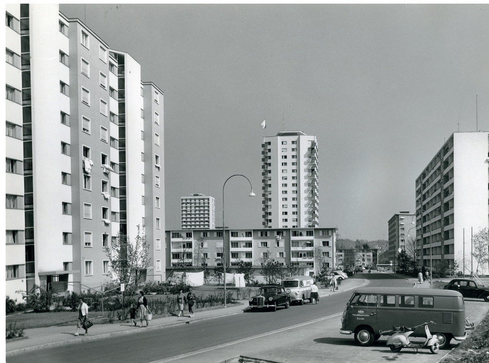
Neubauquartier der 1950er-Jahre an der Hirzenbachstrasse (Bild: BAZ_133293, Carl Hänsler)
