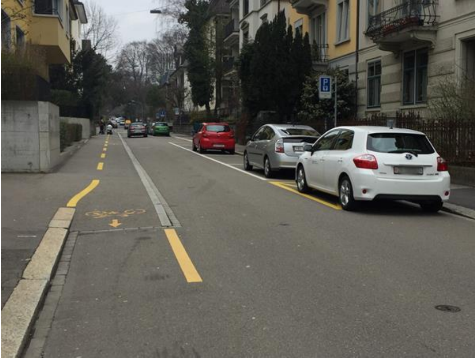
Foto: Freiestrasse mit Mischverkehrsfläche Fuss/Velo auf dem Trottoir (vorher)
