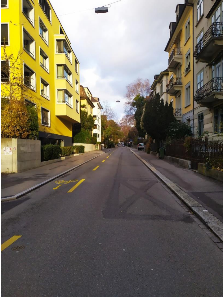
Foto: Freiestrasse mit separatem Velostreifen dank aufgehobener Parkfeldern (nachher)
