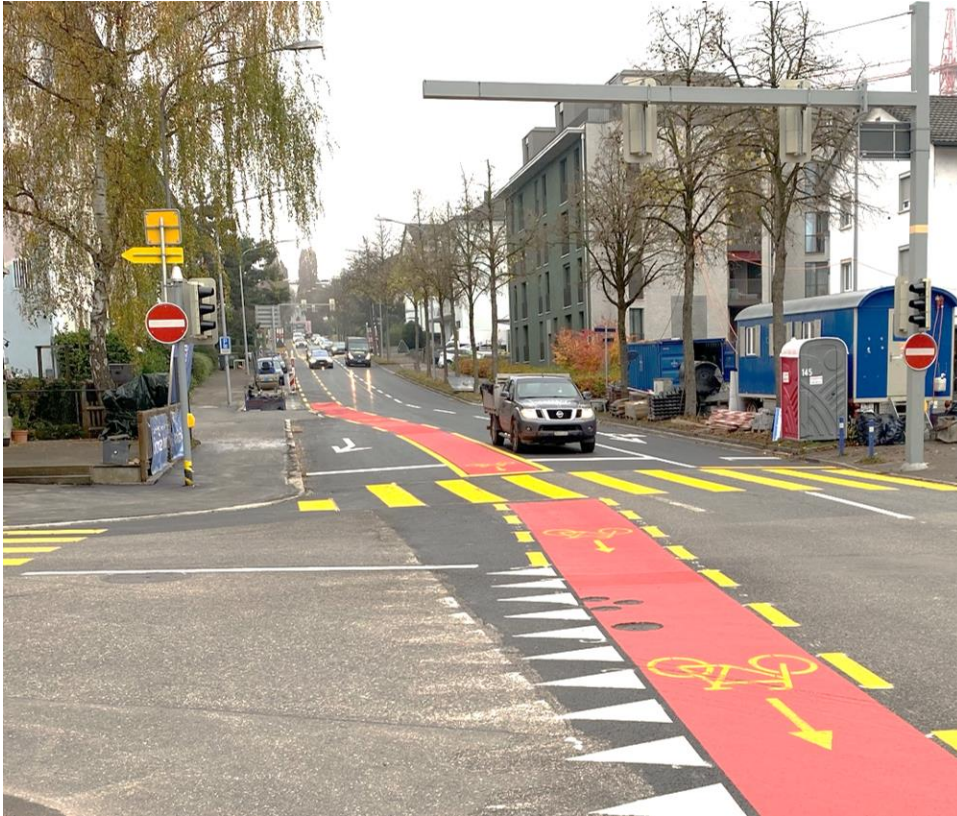
Foto: Unfallherd Dörfli-/Schwamendingenstrasse nach dem Umbau
