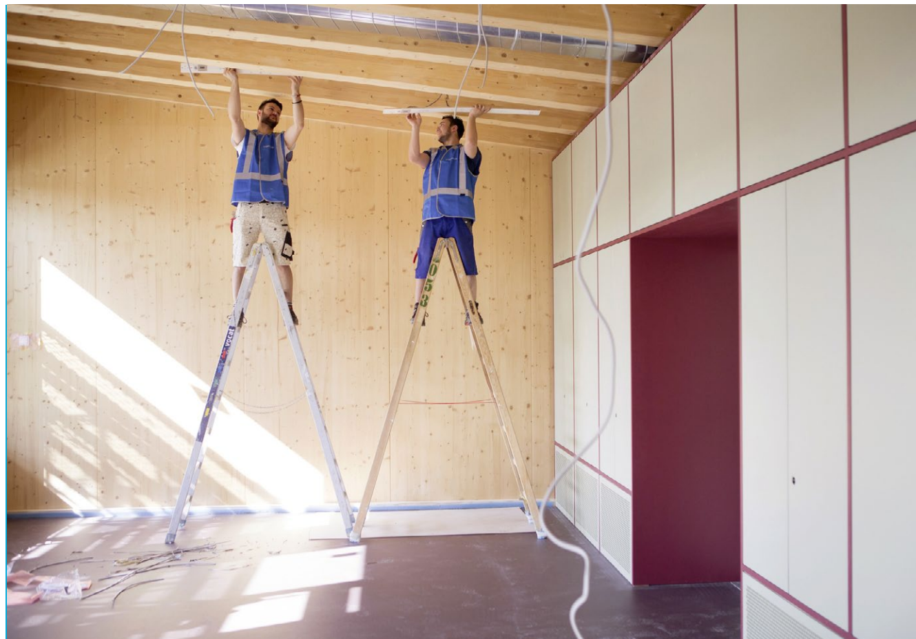
Grosszügige Fensterfronten sorgen in jedem Raum für Tageslicht: Endarbeiten am Aemtler D. Foto: Sabina Bobst
