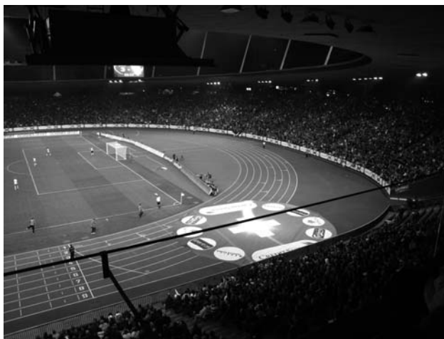
Das neue Letzigrund-Stadion, in Rekordzeit gebaut und in Betrieb genommen. (Bild: Hochbaudepartement)
