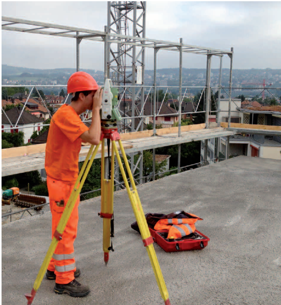
Abb. 3: Ein Mitarbeiter von Geomatik + Vermessung bei der Bauvermessung. Fig. 3: Un collaborateur de Géomatique + Mensuration lors de mesures d'une construction.
