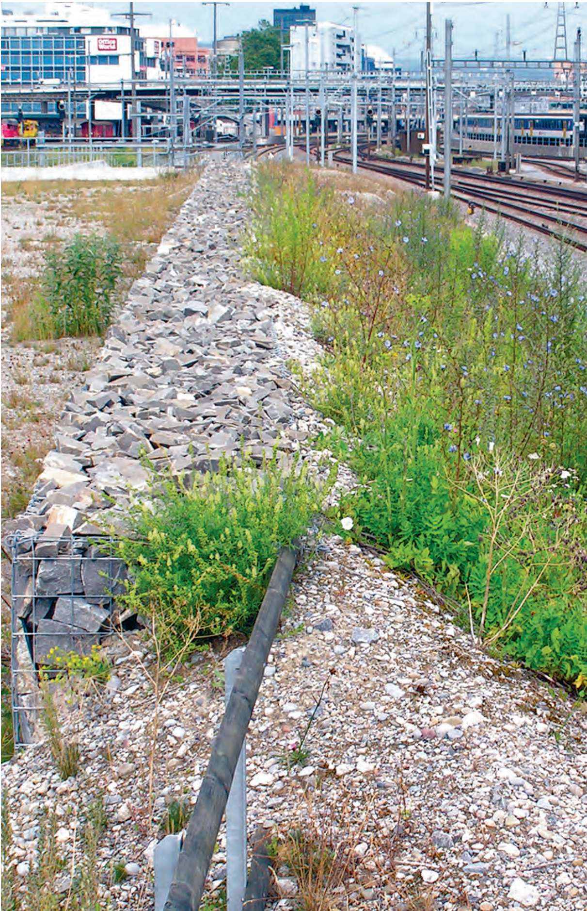
Ausbau dank Ausgleich: kiesige Pioniervegetation, Steinkörbe und Magerwiesen fördern Zielarten am HB Zürich.
