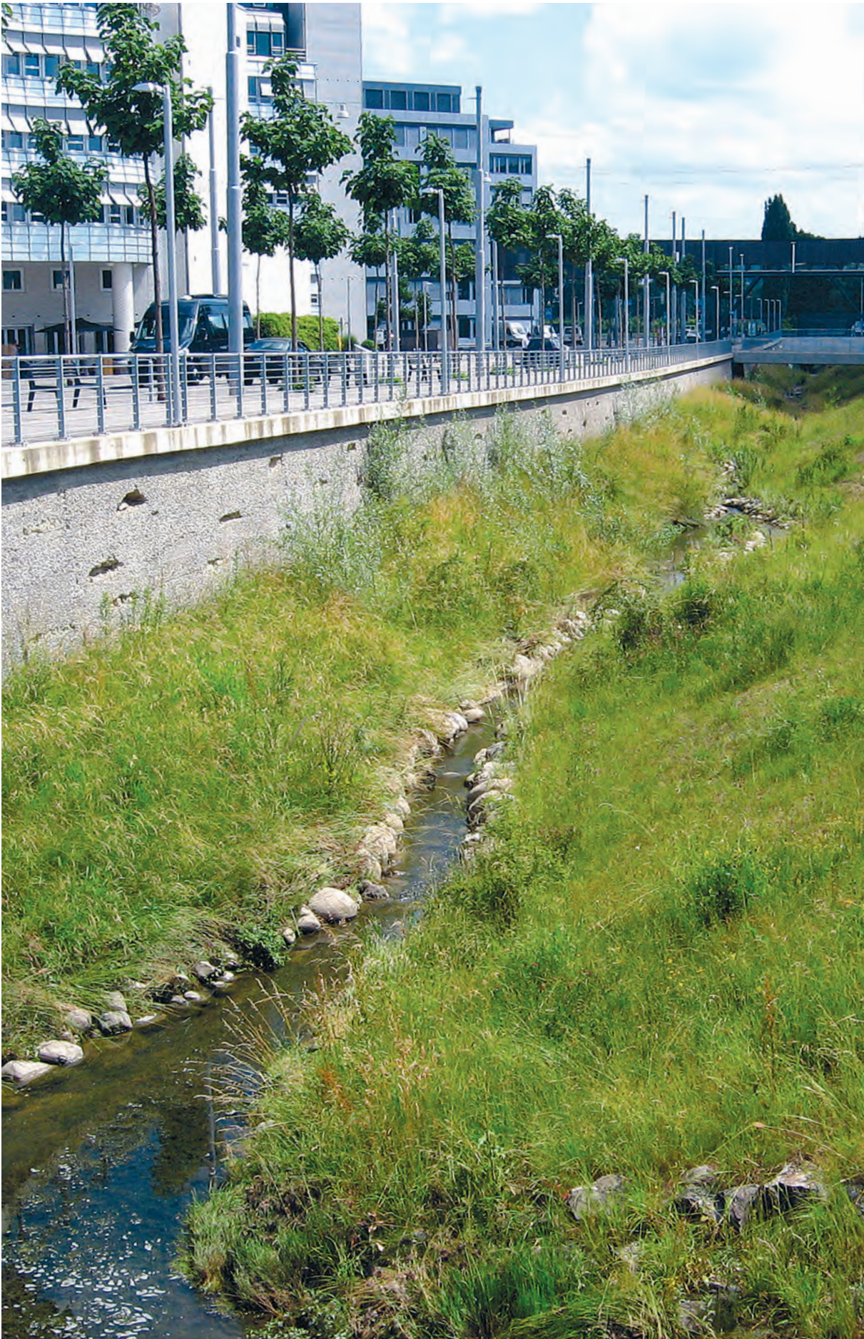
Naturraum im urbanen Rahmen: Renaturierter Leutschenbach und Stampfbetonvormauerung mit Sand- und Lehmlinsen.
