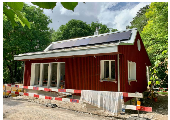
Energetische Sanierung der Waldschule Adlisberg 2021/22
