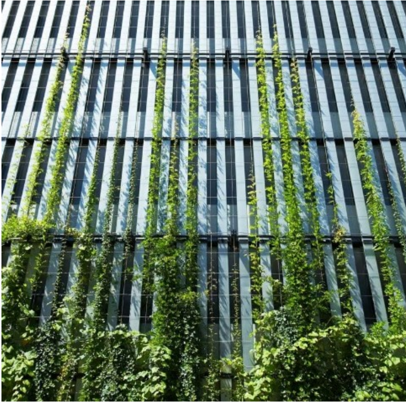
Ansicht Fassade + Rankhilfen © Peter Berger
