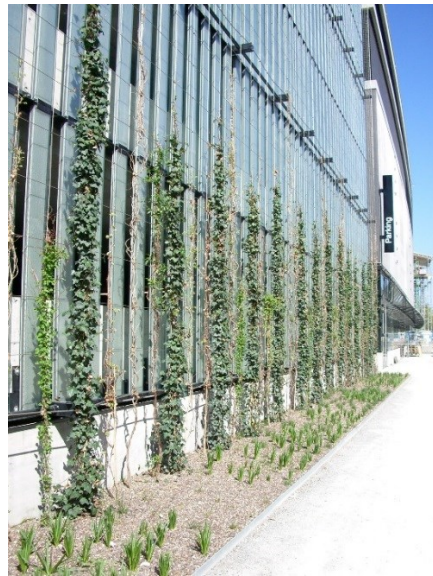
Ansicht Fassade + Rankhilfen © Peter Berger
