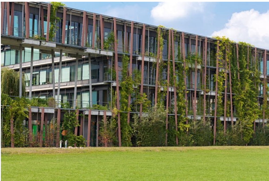
Ansicht Fassade © Christo Libuda, Lichtschwärmer
