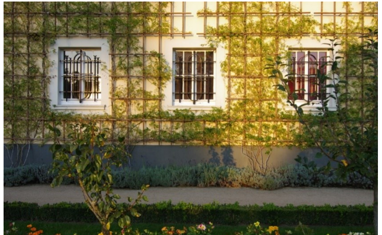
Fassadenansicht frontal im Abendlicht © Nicole Pfoser
