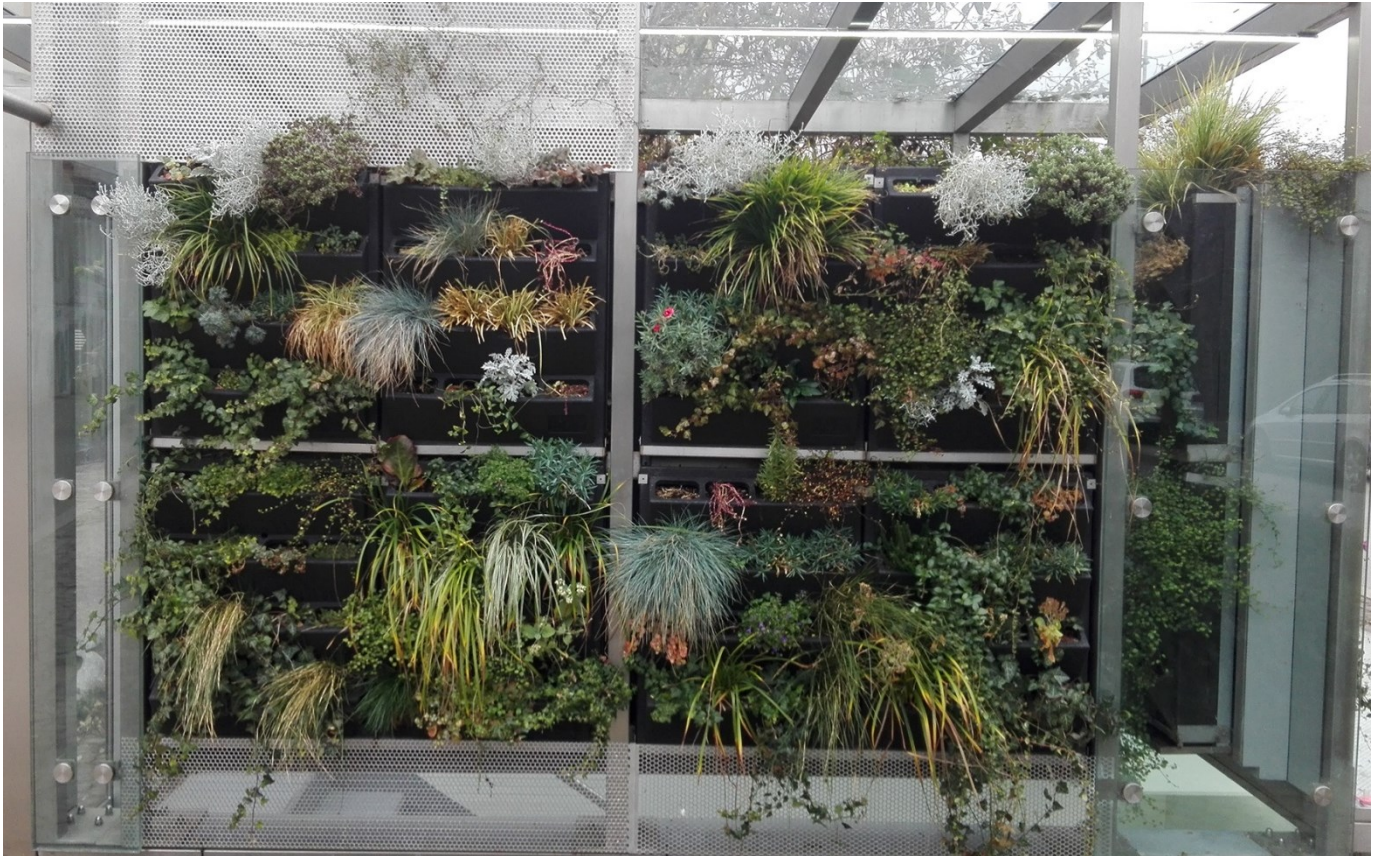
Parkgaragenaufgang Ansicht Begrünung - © „Das Weitzer“, Graz
