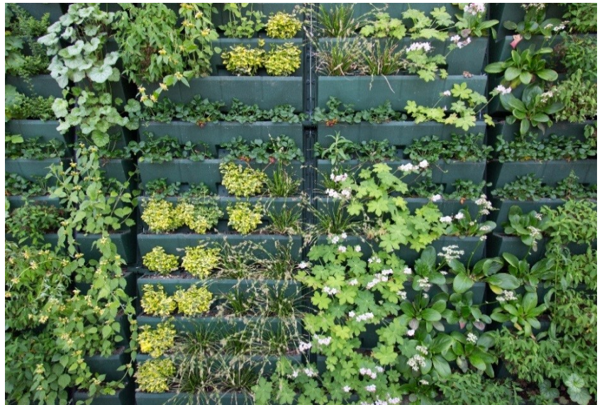
Nahaufnahme modulare Fassadenbegrünung © Ton Desar
