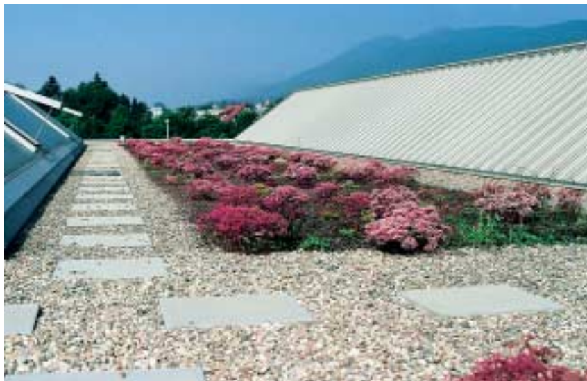
Berechnungen ergaben, dass sich mit Dachbegrünungen in den meisten Fällen auch Kosten sparen lassen. (Bild Sarnafil AG)
