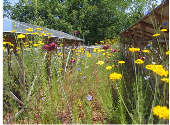
Farbenpracht auf dem Dach durch 35 verschiedene Pflanzenarten
