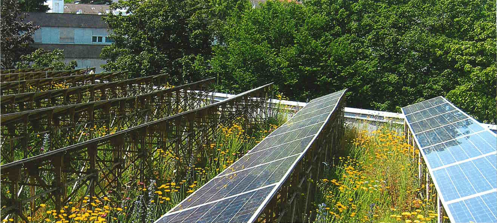
Oben: Dachbegrünung mit Solarzellen, Schulhaus Kugelilloo
