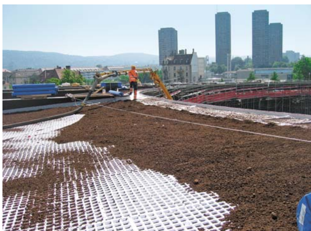
1500 Tonnen Substrat wurden auf das ovale Dach des Stadions gepumpt.
