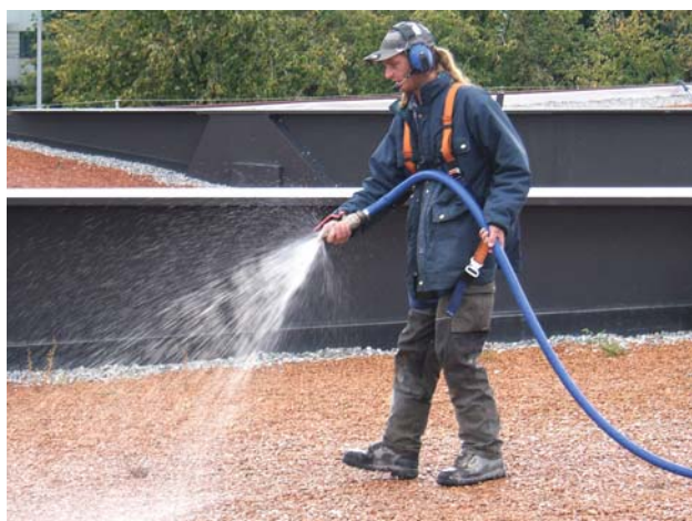
Die Hälfte des Saatguts wurde im September 2007 im Nassspritzverfahren ausgebracht.
