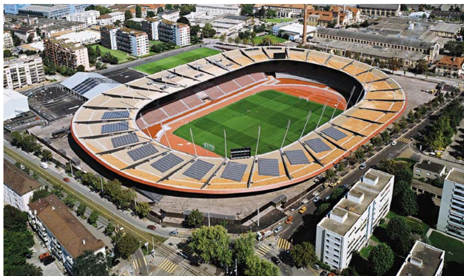
Das Muster, das durch die unterschiedlichen Substrate auf dem Dach des Letzigrundes entstand, soll nach den Plänen der Architektin Marie-Claude Bétrix an einen Wirbelsturm erinnern.
