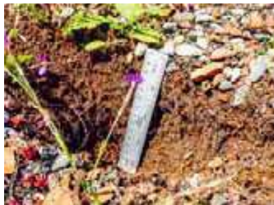
Mindestens zehn Zentimeter (verdichtetes) Qualitätssubstrat. Quelle: GSZ
