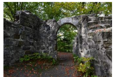
Eingang zur Friesenburg. Foto: P. Rienth
