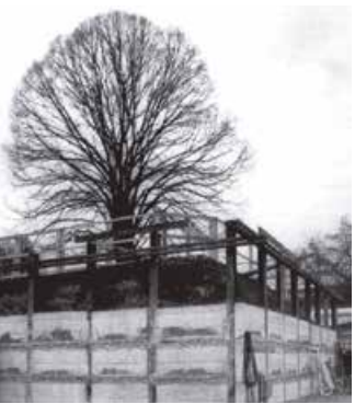
Stützmauern zum Schutz während des Baus. Foto: S. Luckner, Anthos, 1993
