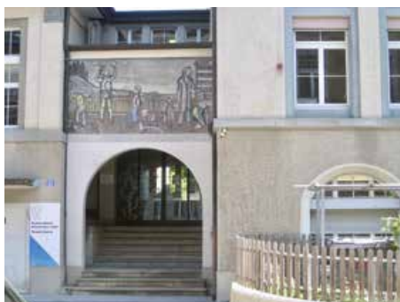
Ehemaliges Pestalozzi-Schulhaus. Über dem Haupteingang ein Wandbild, Pestalozzi darstellend mit Kindern. Foto: Martin Germann, 2020.
