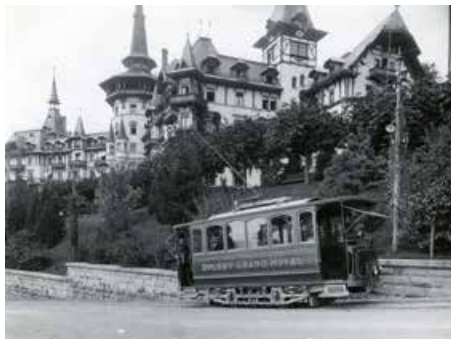
Privatram vor dem Dolder, 1911. Bild: Baugeschichtliches Archiv der Stadt Zürich.
