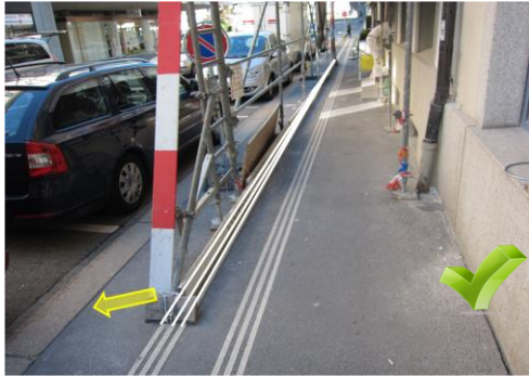
Passerelle verbreitern und Gerüst Randsteininnenkante abstützen
