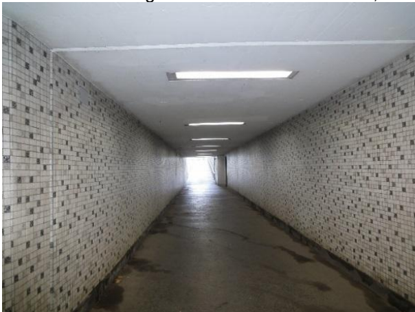
Abbildung 2: Referenzfoto Fussverkehrsanlage (Unterführung)
