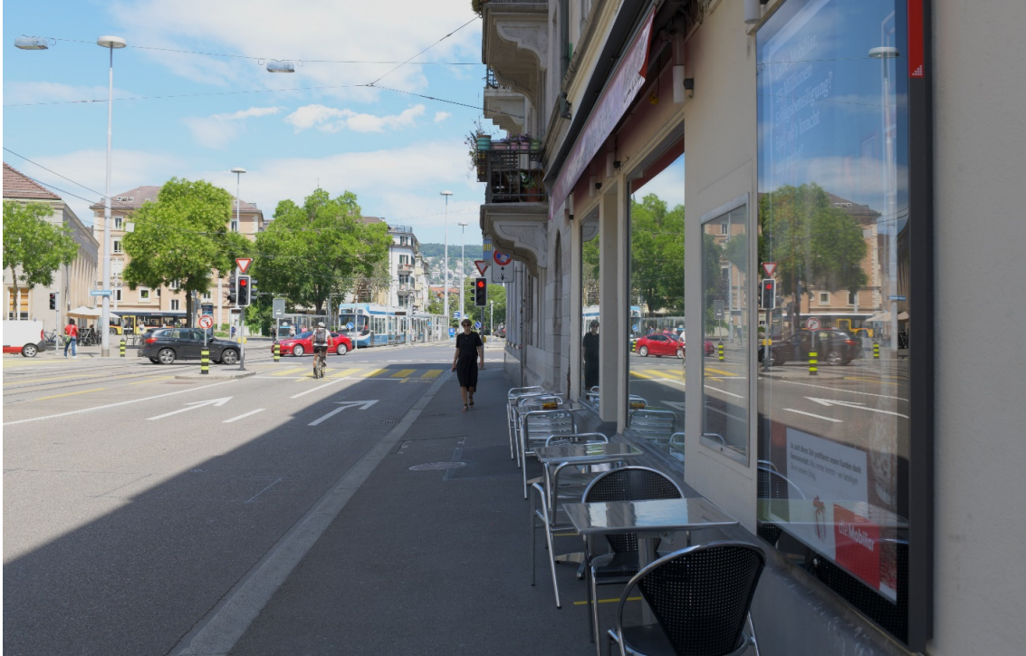
Birnensdorferstrasse (Bedeutung: regional/stadtweit): keine ausreichende lichte Breite, zu geringe Umfeldzuschläge zum Strassencafé und zur Fahrbahn hin
