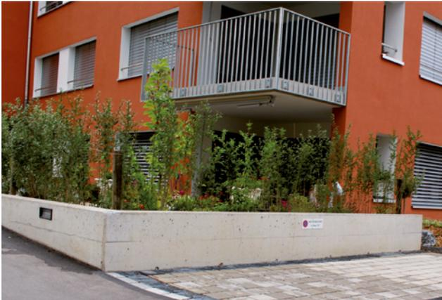
Gebäudeabschirmung durch Mauern und Terrainerhöhung.
