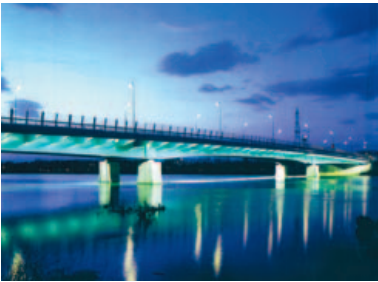
Referenzbild einer gut be- leuchteten Stahlbrücke .
