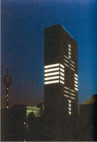
Ein Hochhaus als Plattform der Kunst: Mannesmann-Hochhaus, Düsseldorf.
