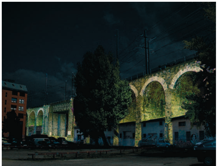
Der alte Letten-Viadukt ist ein wichtiges Element der Stadtgeschichte von Zürich West. Seine räumliche Wirkung ist eng verbunden mit dem Quartier zwischen Limmat und Gleisfeld. Mit der starken Veränderung und der urbanen Neuausrichtung sind solche Objekte in ihrer Symbolkraft zu unterstützen.
