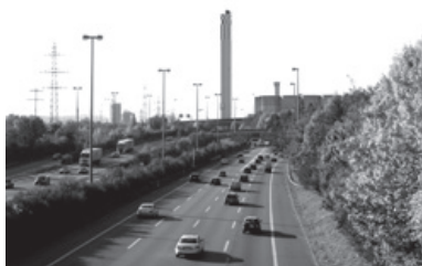
Das markante Heizkraftwerk Aubrugg im Autobahnkreuz.
