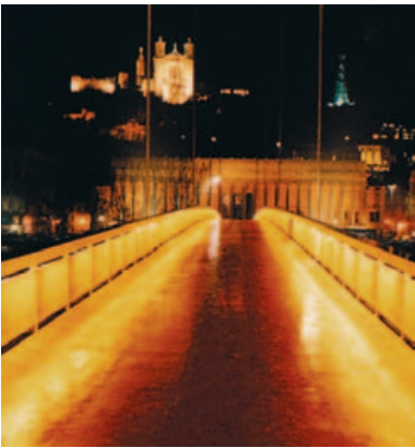
Bei der Fussgängerbrücke über die Saône in Lyon ist die Beleuchtung in den Handlauf integriert.
