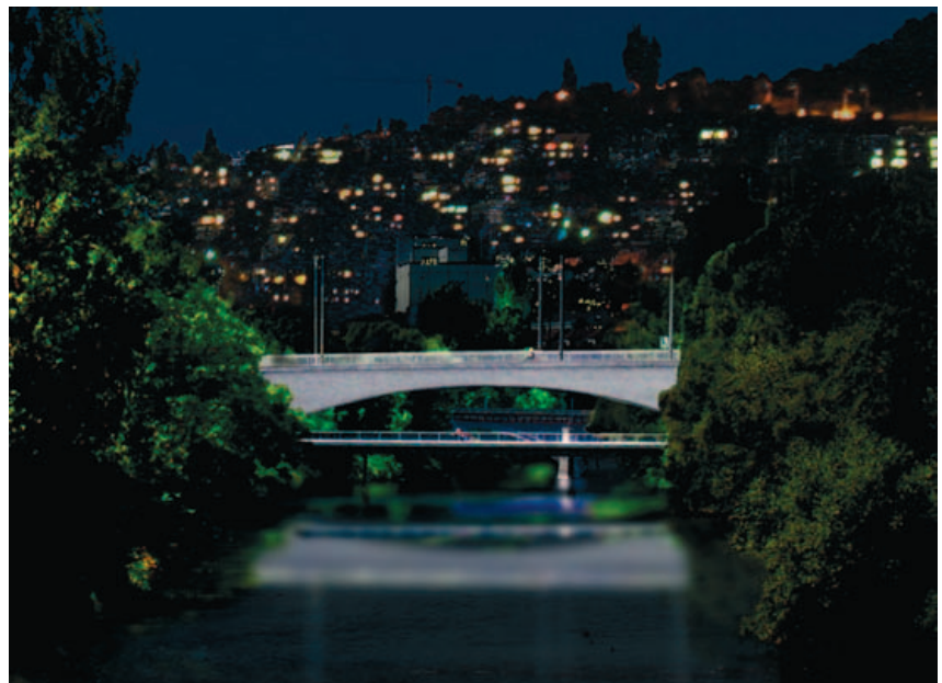
Die beiden Brücken bieten schon mit wenig Licht ein gut erkennbares Ensemble im dunklen Grünraum beim ewz-Kanal.
