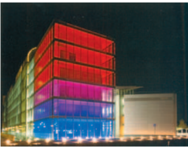
Das von James Turrell inszenierte Verwaltungsgebäude der Verbundnetze AG, Leipzig.
