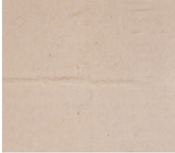
Frontal angeleuchtete Wand
