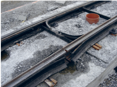
VBZ-Normgleiseinbau: Schienenprofil Ri 60N mit Phoenix- Streustromisolation. Elastische, kontinuierliche Schienenlagerung (maximale Einsenkung 1 mm).
