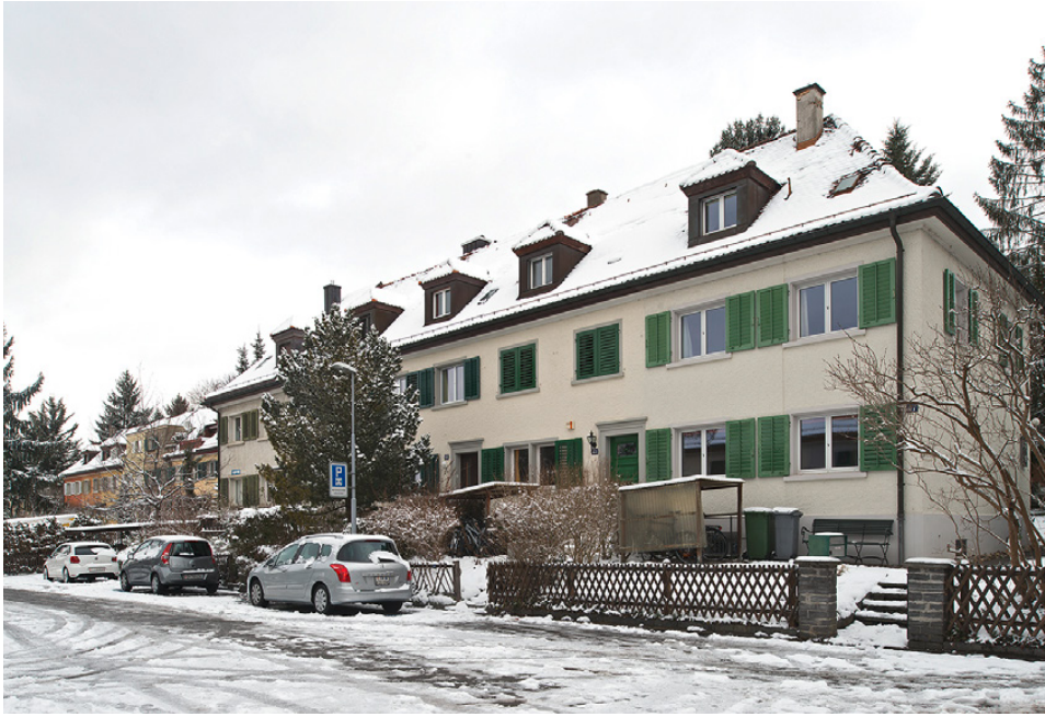
Abb. 23: Siedlung «Zanggerweg» (1926). Reiheneinfamilienhäuser unter durchgehendem Walmdach mit flächigen, regelmässig gegliederten Fassaden; der klassizistisch geprägte, sachliche Heimatstil ist typisch für Kleinhaussiedlungen der 1920er-Jahre. (Foto AfS 2012)
