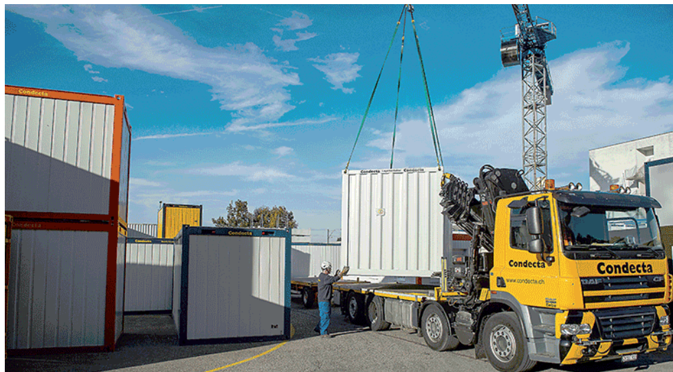
Abb. 7 Dachmodule sollen wie Container mit Kran und Lastwagen transportiert werden
