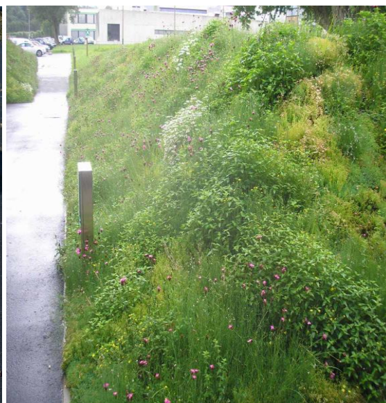
OH-ch Kräuter Rollmatten verlegt an einer Böschung
