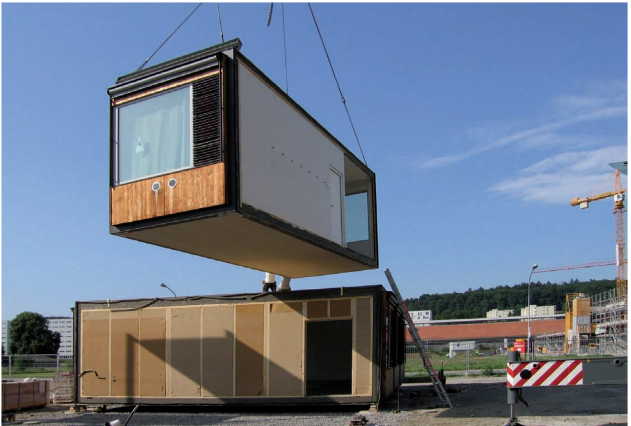
Abb. 45 Installation „Züri-Modular“-Segment bei der Pavillonschule Ruggaecher in Zürich Affoltern
