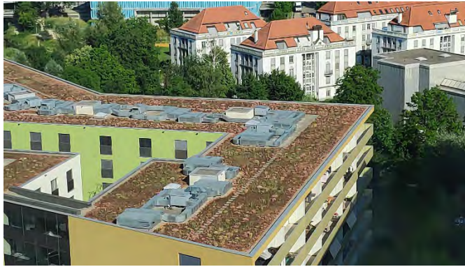
Abbildung 7: Begrünte Dächer (hier neben dem Chriesbach) wirken kühlend und dienen der Wasserretention. Quelle EBP, 2019
