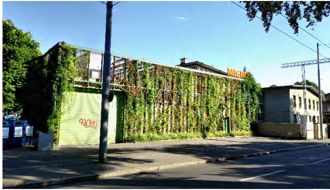
Abbildung 8: Die begrünte Fassade (hier am Provisorium der Migros Kreuzplatz) kühlt die warme Luft des Strassenraums. Quelle EBP, 2019
