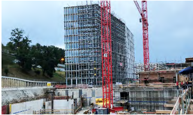
Abbildung 9: Ein Kälteverbundsystem (Green-City in der Manned) vermindert die Abgabe von Gebäudeabwärme an die Umgebung. Quelle EBP, 2019
