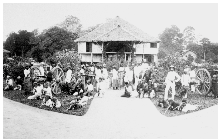
Für den Bau der Plantagen auf Sumatra brauchten die Europäer viel Land. Dabei stiessen sie auch auf den Widerstand der ansässigen Bevölkerung, die zunehmend verdrängt wurde und deshalb die Plantagen wiederholt angriff. Im Bild die Plantage des Bruders von Fritz Meyer, der seine Wehrbereitschaft zeigen will. (Bild: Völkerkundemuseum der Universität Zürich)
