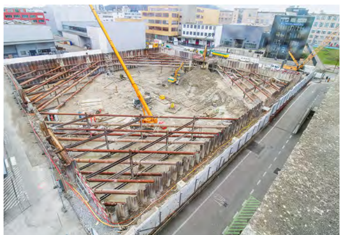
Im Januar 2024 konnten die Bauarbeiten fortgesetzt werden.
