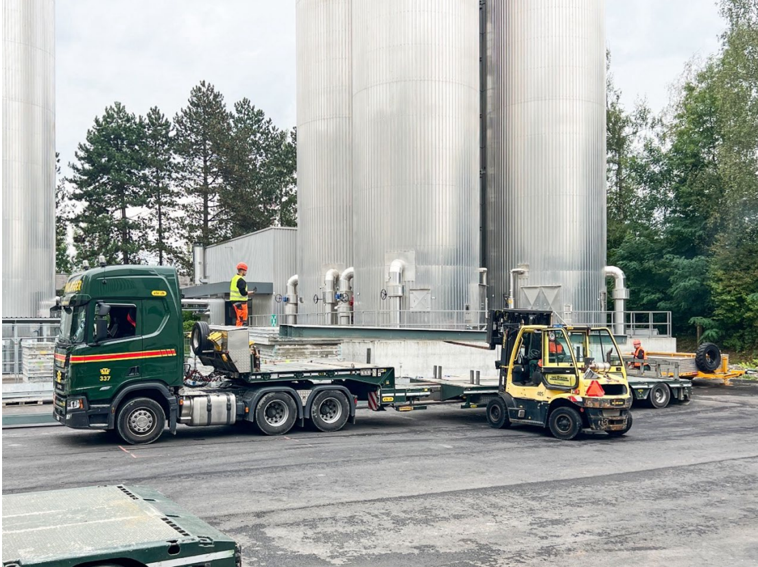
Abb.24 Aufladen der Stahlträger für Transport (© ZHAW IKE, 16.09.2024)
