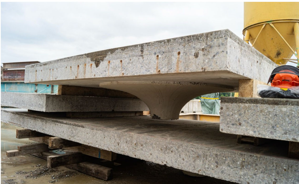
Abb.50 Die Deckenelemente werden mit Hilfe von Kanthölzern gestapelt und gelagert. (© ZHAW IKE, 07.05.2025,)
