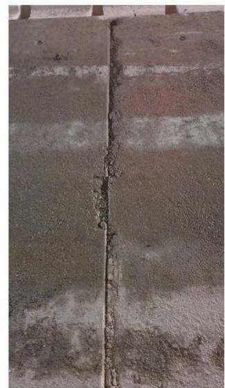
Beschädigte Kanten
