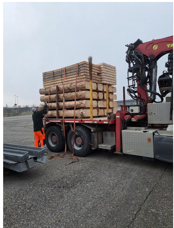
Abb.33 Kanthölzer wurden bestellt für die fachgerechte Lagerung der Platten (© Zirkular, 03.01.2024)
