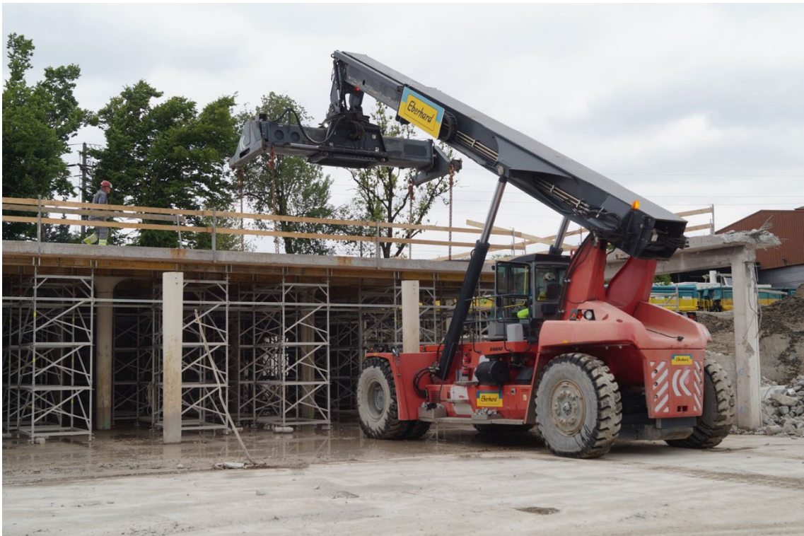
Abb.48 Der Greifstapler fährt eine geschnittene Platte an (© ZHAW IKE, 07.05.2025)
