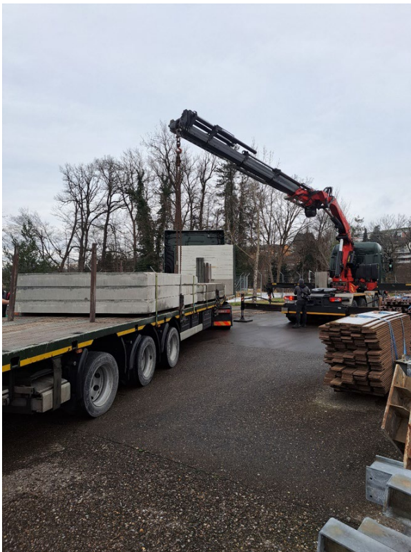
Abb.32 Der Transport der Tunnelplatten zum Lagerplatz auf dem Juch-Areal (© Zirkular, 15.01.2024)
