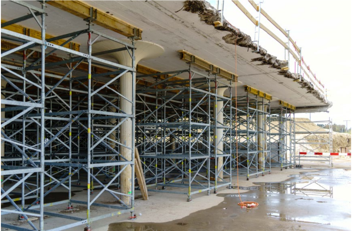
Abb.44 Die durch Bauspriessen gesicherte Halle. Die Stützen wurden bereits unter dem Pilzkopf geschnitten. (© ZHAW IKE, 14.04.2025)
