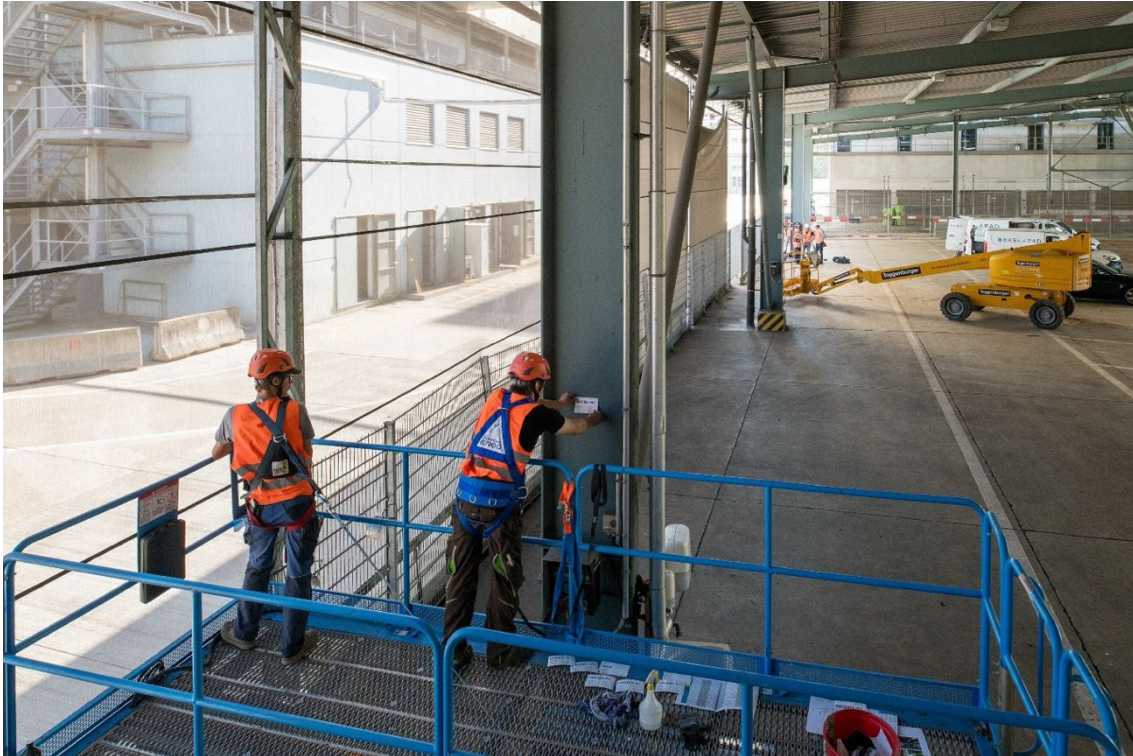
Abb.22 Etikettierung der Stahlträger (© Juliet Haller, 06.08.2024)
