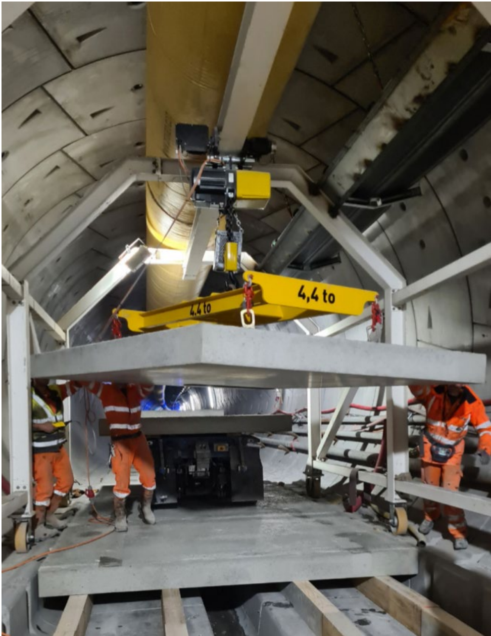
Abb.30 Abbau der Tunnelplatten (© Zirkular).
