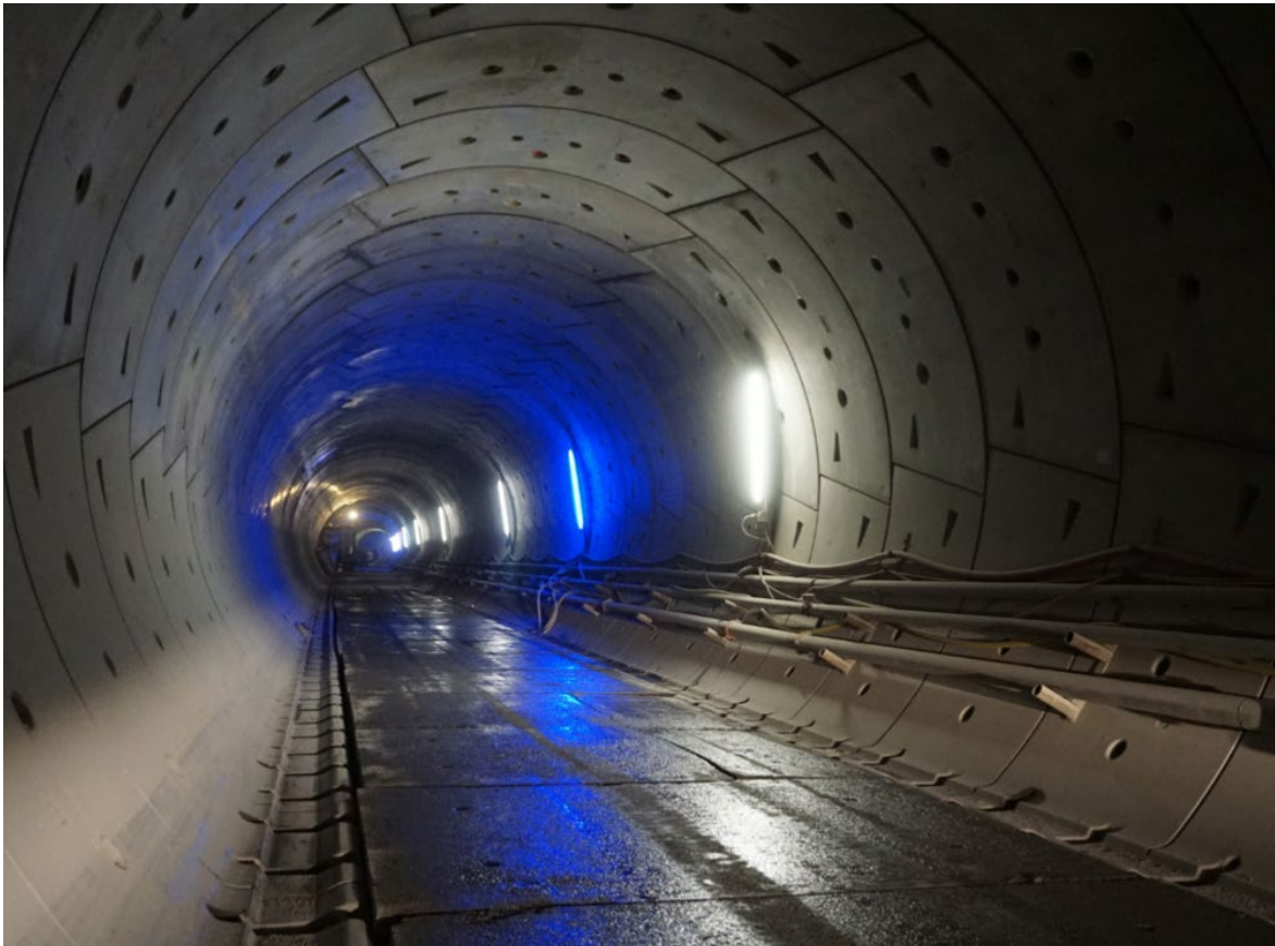
Abb.27 Kerenzerbergtunnel: die Faserbetonplatten der Fahrbahn werden im Projekt Juch-Areal wiederverwendet. (© Zirkular)
