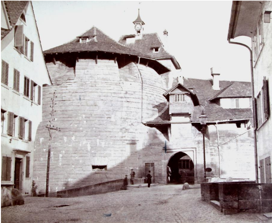
Abbildung 13: Bildquellen: Wikipedia; Foto von Rudolf Ganz vor dem Abbruch.
