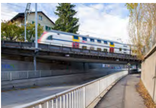
Strassenunterführung Seestrasse Wollishofen
