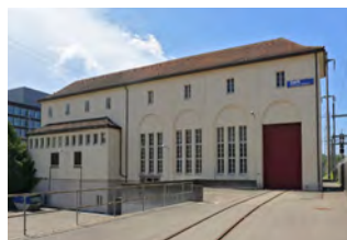
Unterwerk Seebach, Dienstgebäude
