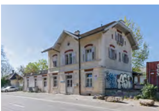
Bahnhof Letten und Lettentunnel
