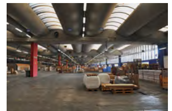
«Schnellgut-Stammbahnhof» Zürich Altstetten
