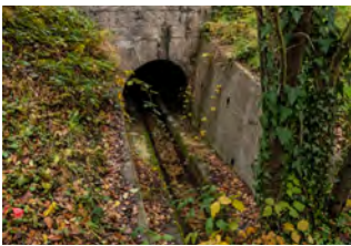
Durchlass Unterdorfbach Altstetten
