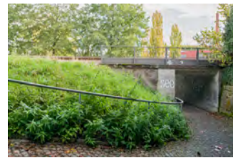
Bahndamm Wollishofen mit Unterführungen
