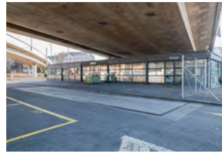
Dienstgebäude mit Brückenwaage
