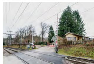
Nationalbahnstrecke Affoltern bis Seebach
