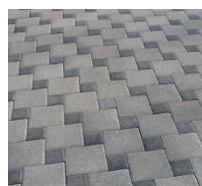
Sickerbetonstein mit schmalen Fugen
