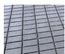
Sickerbetonstein mit brei- ten Fugen
