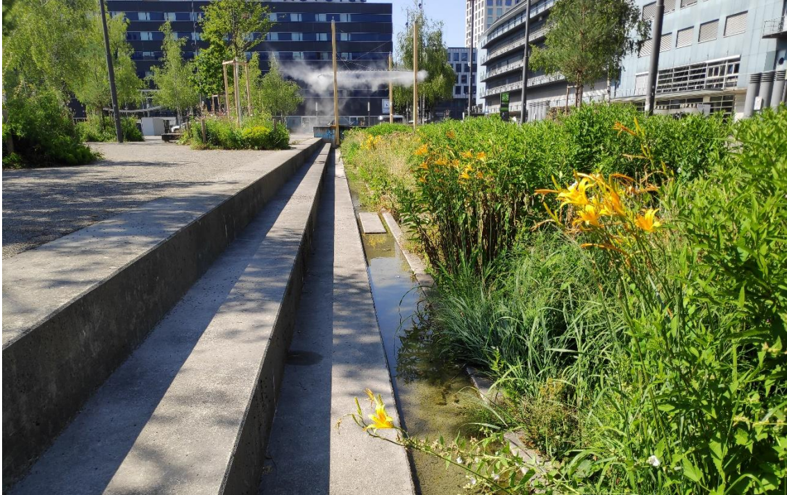
Abbildung 2: Multifunktionales Versickerungsbecken, Turbinenplatz Zürich
