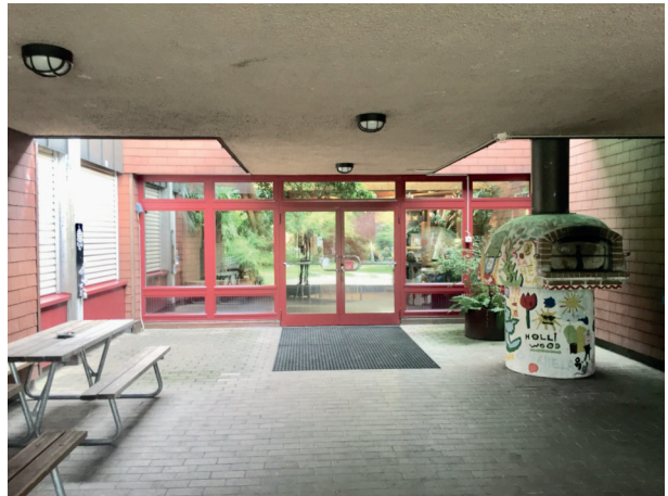
Fassade West Eingang Park
