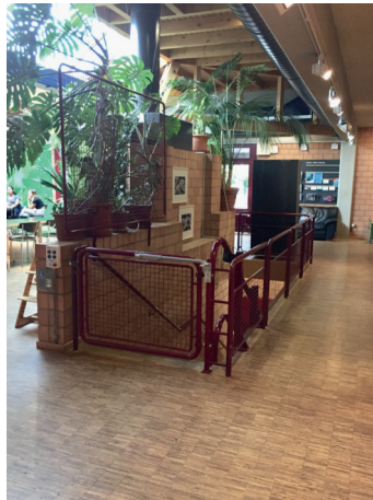
Foyer Treppe zum UG
