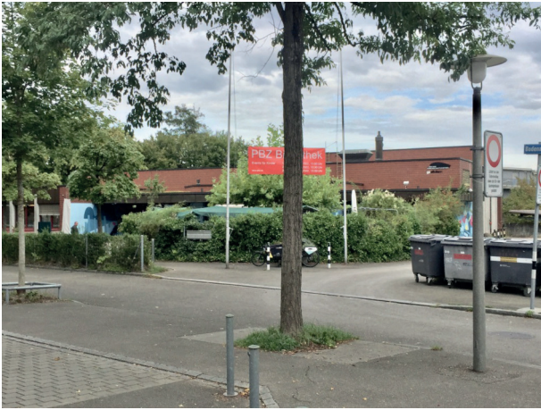
Fassade West Eingang Park
