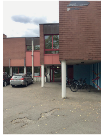
Fassade Nord Eingang UG
