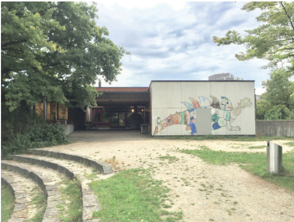
Fassade West Eingang Park
